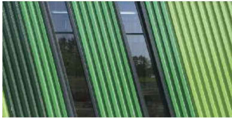
Project: Gemeentewerf in Waalwijk, Nederland Architect: © Van Aken Architecten Fotografie: © 2013 ArcelorMittal, alle rechten voorbehouden
