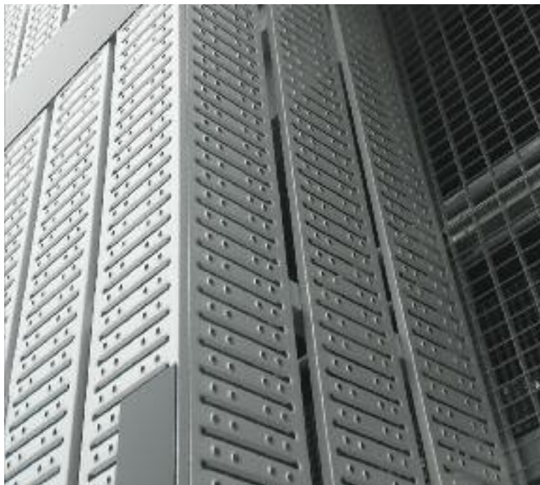
Project: Mazelle-parking in Metz, Frankrijk Architecten: © Christophe Mariotti, Mariotti & Associés Fotografie: © Julien Cescon
